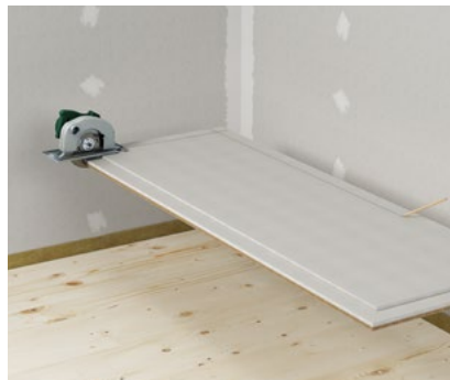
2 Absägen des überstehenden Falzes für eine erste Verlegereihe
