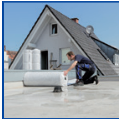
Drainagematte auf durchwurzelungsfester Abdichtung bündig ausrollen. Vliesüberlappung an Längsseite schließen.
