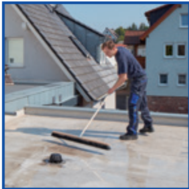
Reinigen der Dachfläche.
