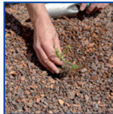
Pflanzen setzen und Sedumsprossen mit Rechen einarbeiten.
