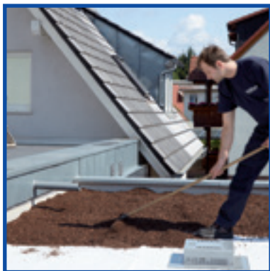
Substrat gleichmäßig verteilen.
