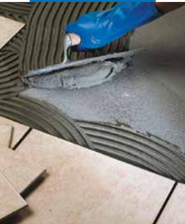
Fliesenverlegung mit Adesilex P9
