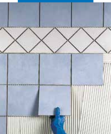
Ansetzen von Fliesen auf Gipskarton
