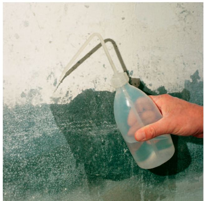
Die Wand konnte ausreichend gut entölt werden. Das hier zur Demonstration aufgesprühte Wasser dringt etwas ein und perlt nicht sofort ab.
