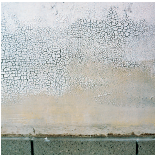
Aufgetragener pastöser PCI Entöler bindet die gelösten Verschmutzungen und trocknet krustenartig aus.
