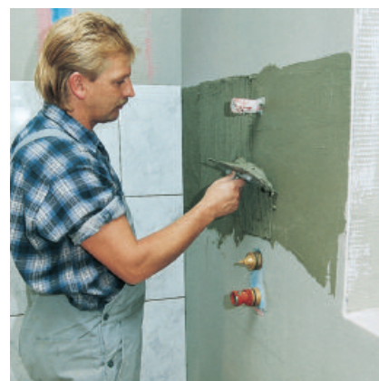
PCI FT Extra ist standfest, die angesetzten Fliesen haften sofort, können aber in ihrer Lage korrigiert werden.
