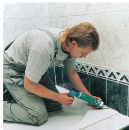
Eck-, Anschluss- und Bewegungsfugen elastisch schließen.
