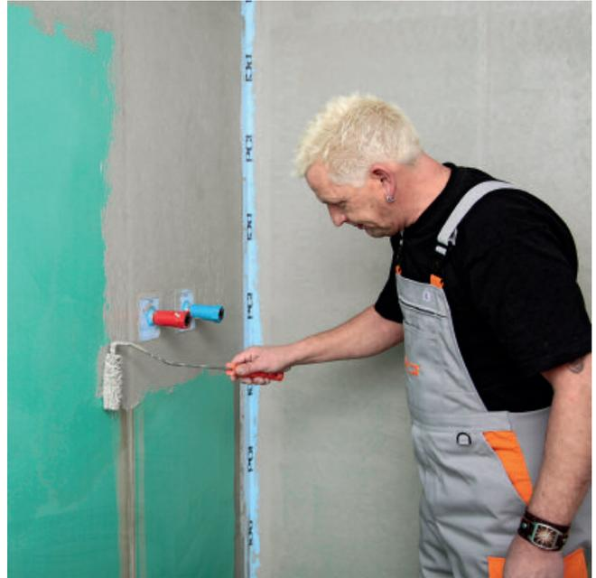
4. Erste Schutzschicht mit PCI Lastogum (grau) unverdünnt satt und oberflächendicht auf den Untergrundaufträgen.
