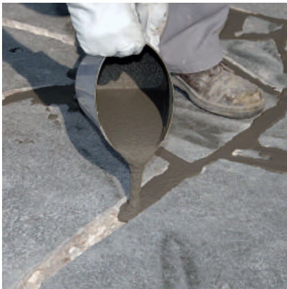
PCI Pavifix CEM mit einem geeigneten Gießgefäß in die vorbereiteten Fugen einbringen.
