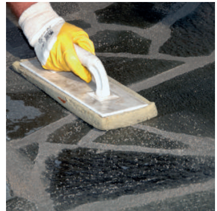
Innerhalb 1 Stunde Plattenbelag mit dem Schwammbrett nachwaschen.
