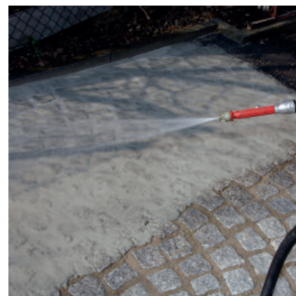
Um beim Reinigen der Pflastersteine ein Ausspülen der Fugen zu vermeiden, ist der Wasserstrahl nahezu horizontal zur Oberfläche zu halten.
