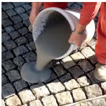
Beim Schlammverfahren lässt sich PCI Pavifix CEM mit einem Gummischieber leicht in die Fugen einbringen.
