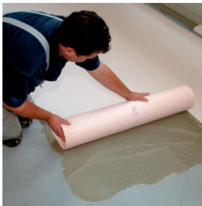
werden die PCI Pecilastic-Bahnen eingelegt...
