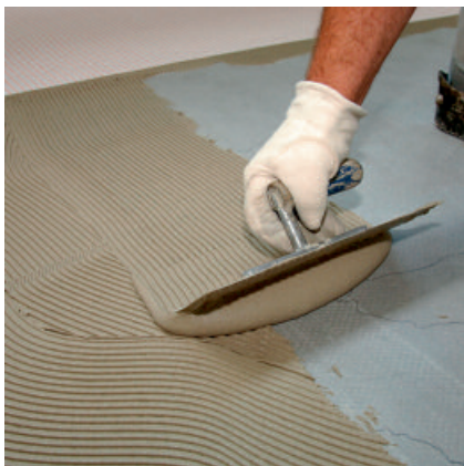
In das frisch aufgekämmte Kleberbett...
