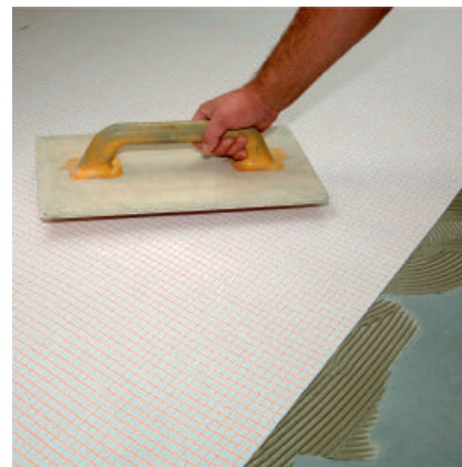
und mit einer Gummiwalze oder einem Holzbrett angedrückt.
