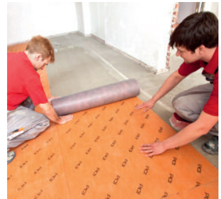
Keramische Beläge können auf der Abdichtungs- und Entkopplungsbahn PCI Pecilastic U funktions sicher verlegt werden.
