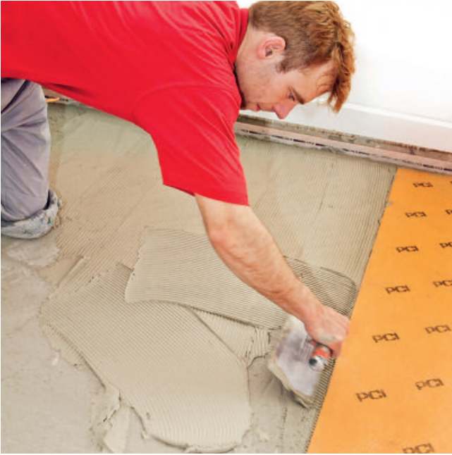
Auf dem vorbereiteten Untergrund PCI Nanoflott light oder PCI Rapidflott aufkämmen...
