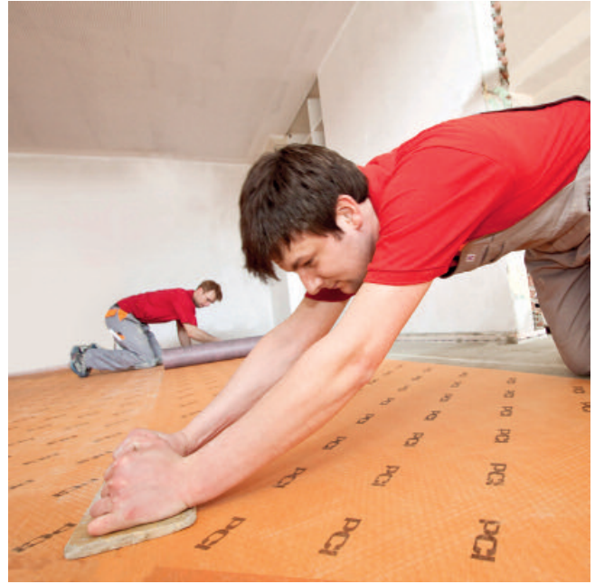
PCI Pecilastic U einlegen und fest andrücken, z. B. mit einem Holzbrett oder Hartgummi-Fugbrett.
