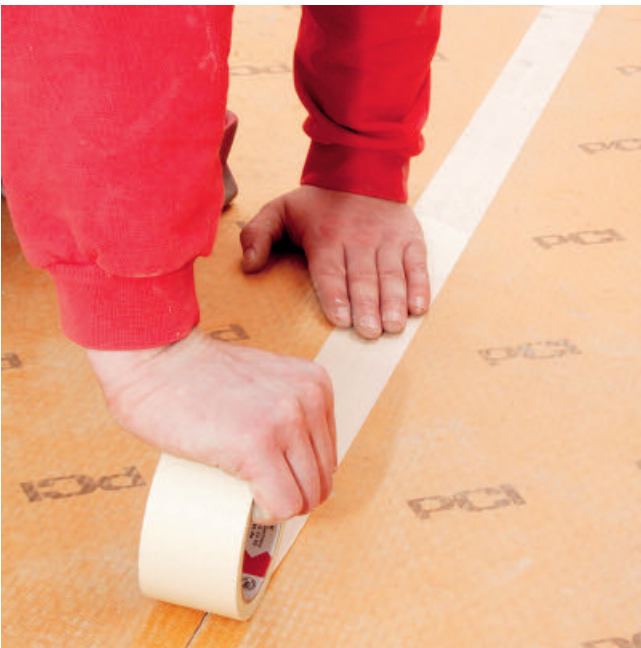
In Trockenbereichen die Stöße mit Kreppband sichern, in Bereichen mit Feuchtigkeitsbelastung mit PCI Pecitape abdichten...
