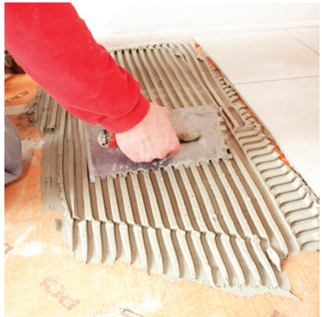
und mittels PCI Nanoflott light oder PCI Rapidflott den neuen Keramikbelag verlegen.
