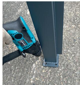
Die Pfostenfüße mit den Dübelbolzen im Beton befestigen.
