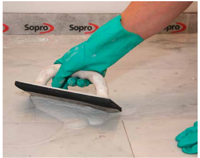
8 Einfugen von Sopro DF 10® in verfärbungsempfindlichen Naturstein.
