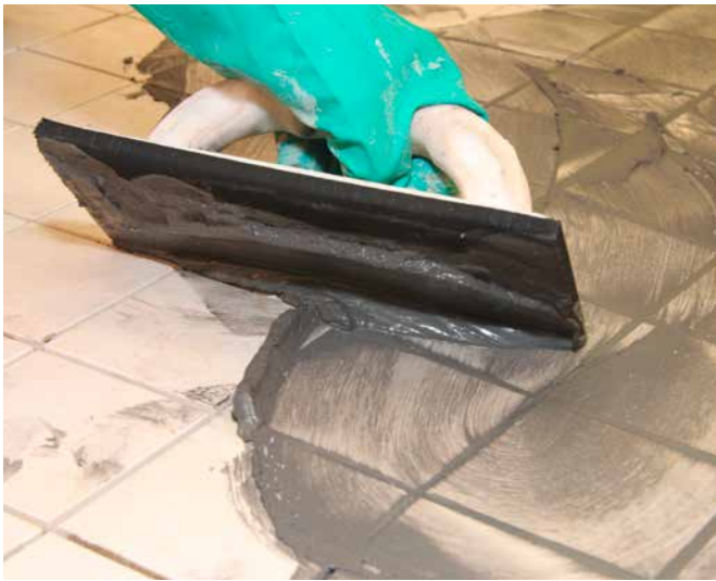
7 Einfugen von Sopro DF 10® in Feinsteinzeugfliesen.
