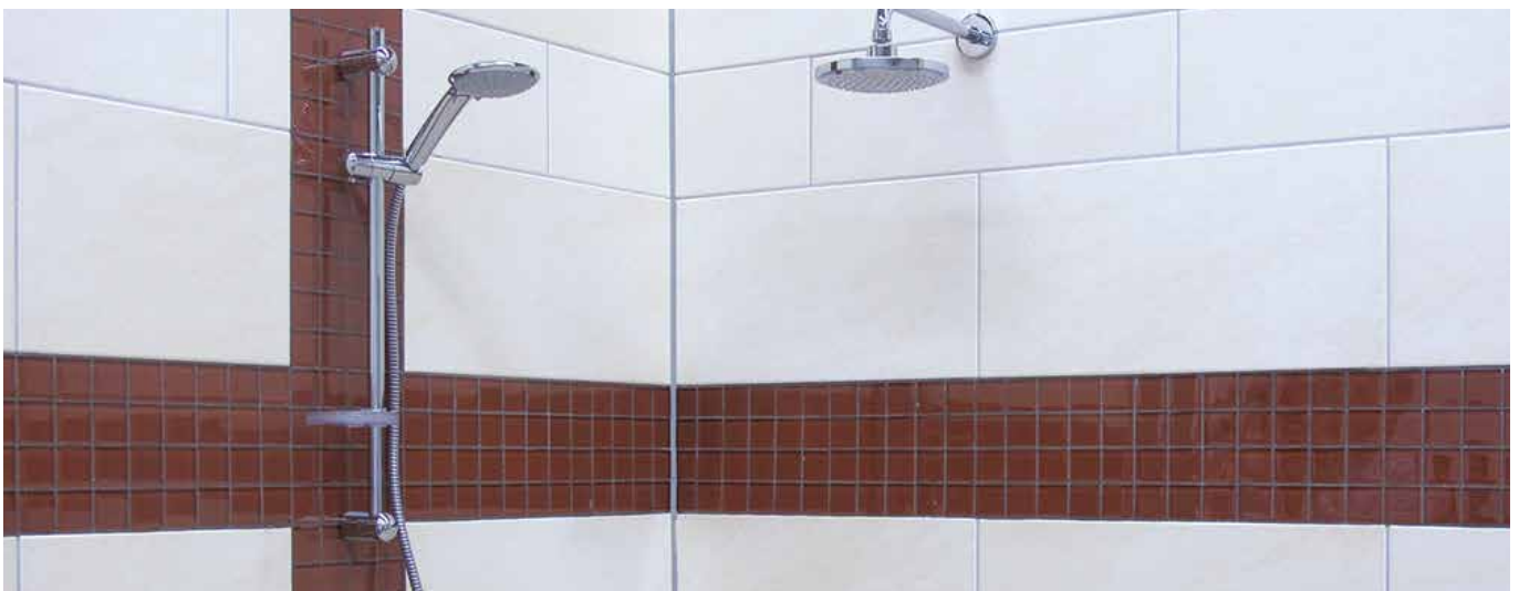
11 Farbbrillante Fugenflächen im Badezimmer.
