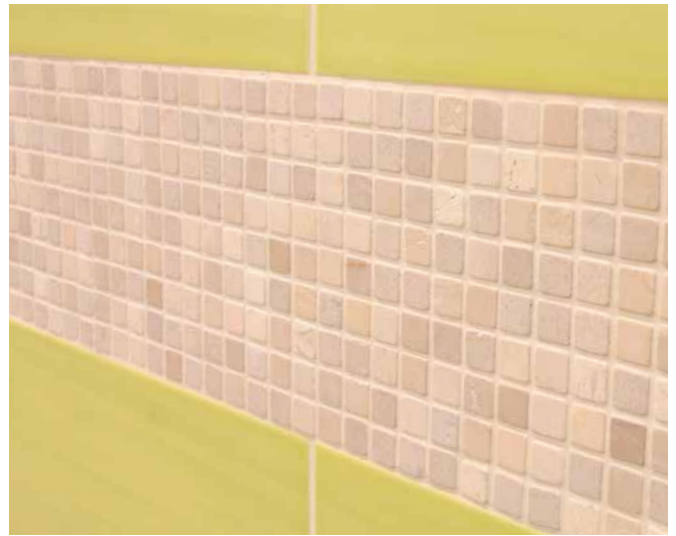
10 Steingut- und Natursteinmosaikflächen verfugt mit Sopro DF 10®.
