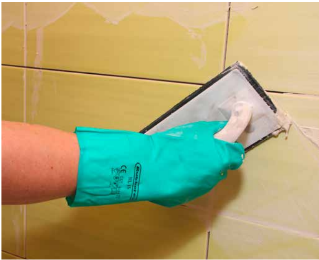
9 Einfugen von Sopro DF 10® in Steingutfliesen.
