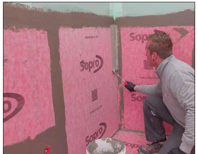
**10** Stoßbereiche der Sopro AEB® Abdichtungs- und Entkopplungsbahn werden mit Sopro AEB® Dichtband Flex überarbeitet.
