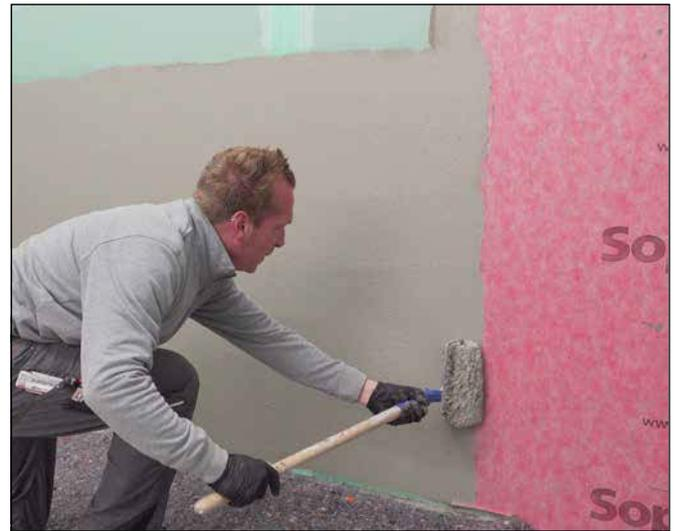
**8** Die Überlappungen der Sopro Abdichtungs- und Entkopplungsbahn ca. 5 cm mit Sopro Fixier- & DichtKleber überarbeiten.
