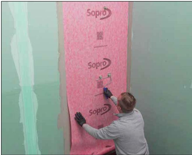
**7** Die passgenau zugeschnittene Sopro AEB® Abdichtungs- und Entkopplungsbahn in die frische Klebeschicht einlegen und von der Mitte her fest andrücken.
