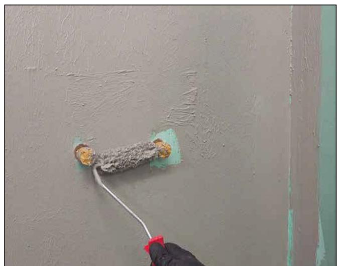
6 An engen Stellen oder Durchdringungen den Auftrag mit einer kleinen Rolle oder einem Pinsel durchführen.
