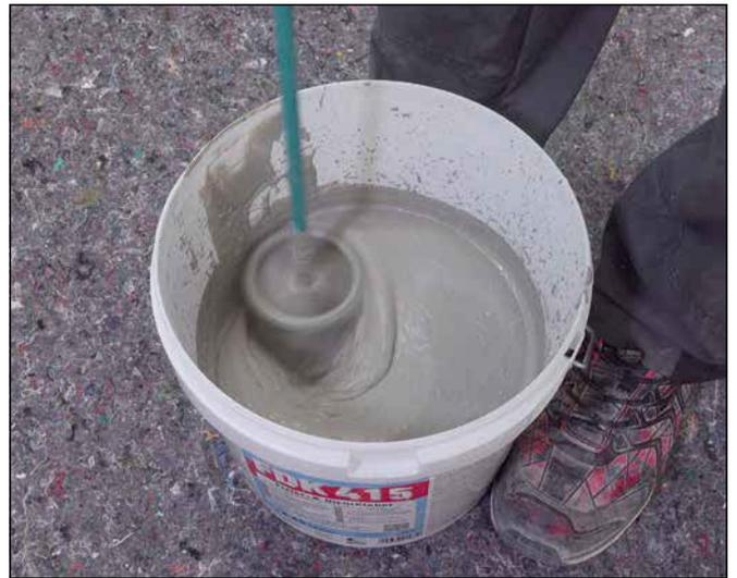
2 Flüssigkomponente B vorgeben und mit der gesamten Menge der Pulverkomponente A maschinell klumpenfrei anmischen.
