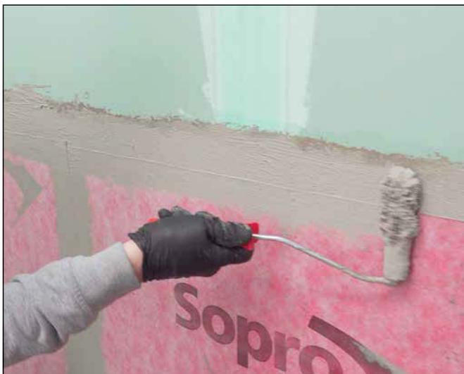
**9** Die Abschlüsse der Sopro AEB® Abdichtungs- und Entkopplungsbahn mit Sopro Fixier- & DichtKleber überarbeiten.
