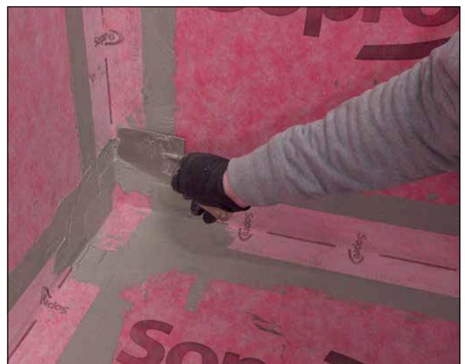
**12** Die Abschlüsse des AEB® Dichtband Flex werden im Anschluss ebenfalls mit Sopro Fixier- & DichtKleber überarbeitet.
