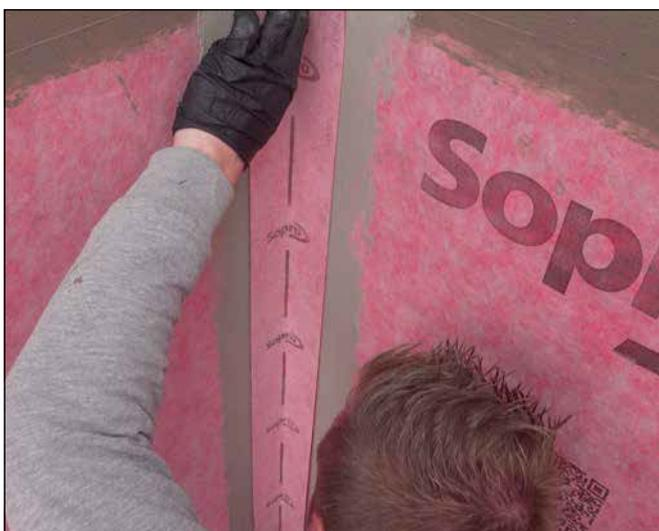
**11** Das passgenau zugeschnittene Sopro AEB® Dichtband Flex in die frische Klebeschicht einlegen und fest andrücken.
