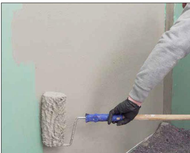
5 Für ein gleichmäßig deckendes Ergebnis Sopro Fixier- & DichtKleber im Kreuzgang auftragen.
