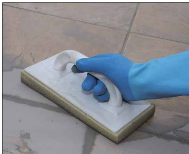
22 Abwaschen des Fliesenbelags nach ausreichender Standzeit der eingefügten Sopro Fugenmasse.
