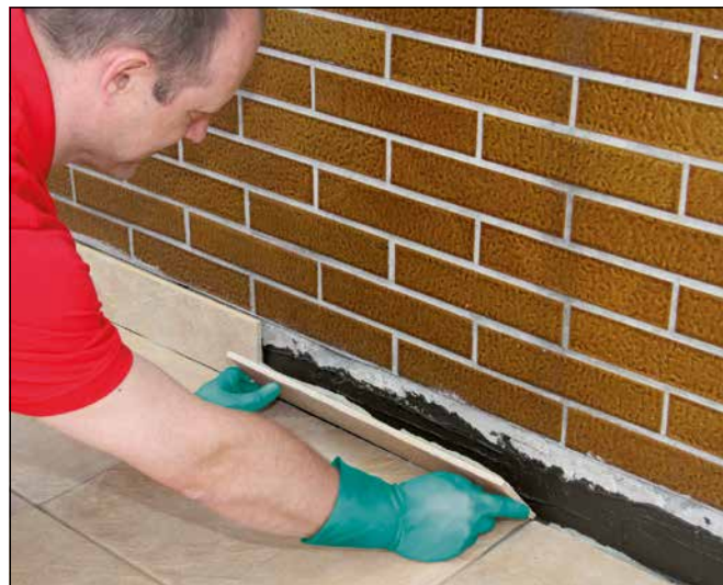
20 ... und Ansetzen der Sockelfliese.
