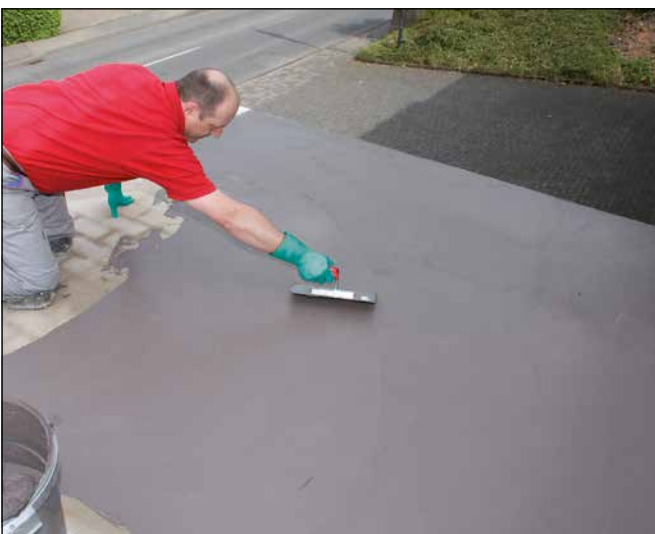
11 Glätten der Sopro TurboDichtSchlämme 2-K mittels Glättkelle.
