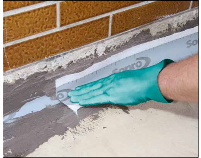
8 ... des anschließend eingelegten Sopro Dichtbandes. Dieses ist zusätzlich einzudrücken.
