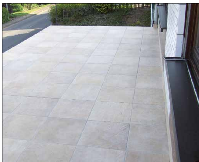
24 Neu verlegter Fliesenbelag auf einem Balkon mit den Sopro Systemkomponenten.
