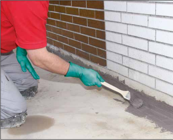
7 Einstreichen des Sockelbereiches mit Sopro TurboDichtSchlämme 2-K zur Fixierung ...
