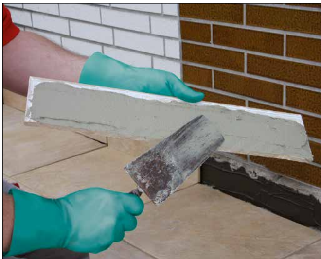
19 Auftragen eines Sopro Flexklebers (z.B. Sopro's No.1, Sopro FKM® XL) auf die Rückseite der zurechtgeschnittenen Sockelfliese ...
