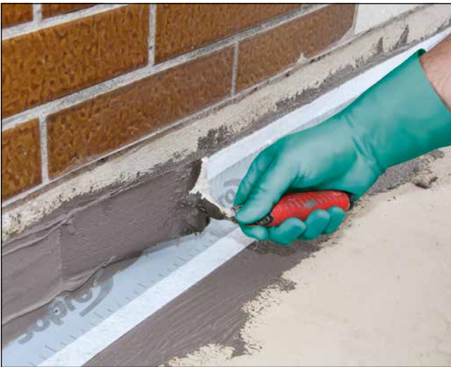
9 Überarbeiten des Sopro Dichtbandes mit Sopro TurboDichtSchlämme 2-K.
