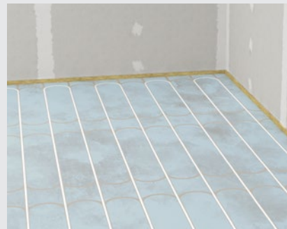
Fertig ausgegossene Therm25™ Elemente (Q1)
