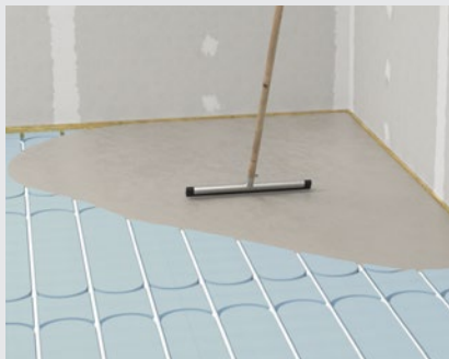
Ausgießen der Therm25™ Elemente mit fermacell™ Ansetzbinder
