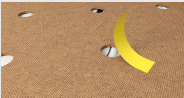
Auflegen der Schablone im geplanten Bereich der fermacell® Gipsfaserplatte als Abdeckplatte. Kontrolle, ob sich Heizrohre im Befestigungsbereich befinden. Falls ja, Befestigungspunkt mit Klebeband abdecken.
