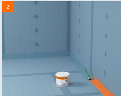
fermacell™ Flüssigfolie in der Ecke auftragen
