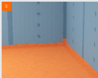
Vollflächige Abdichtung der Fläche im Bereich W1-I
