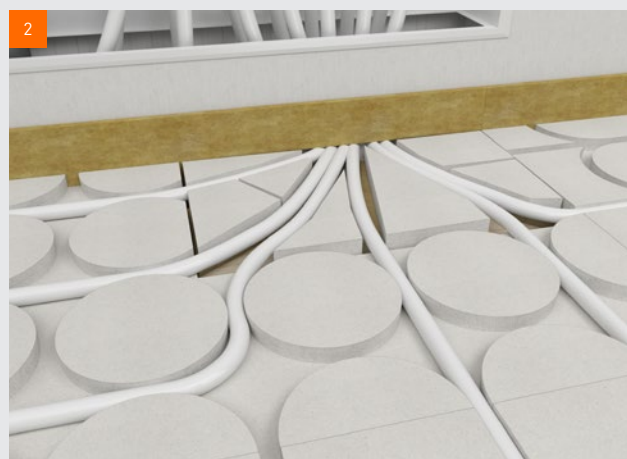
Offen lassen und mit Füllstücken aus fermacell® Gipsfaserplatten ergänzen
