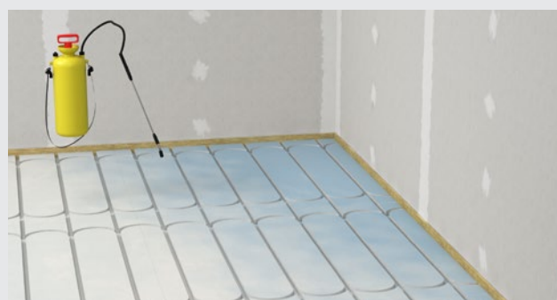
Grundieren der fermacell® Therm25™ Elemente mit fermacell™ Tiefengrund
