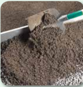
Mörtel aufbringen und über Lehren abziehen
