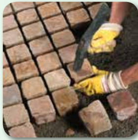
Pflaster hammerfest setzen
