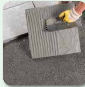
bei Platten unterseitig Haftschlämme auftragen
