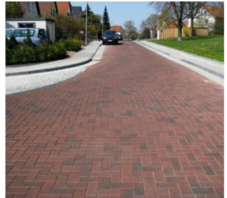
Klinkerpflasterfläche mit Verkehrsbeanspruchung
